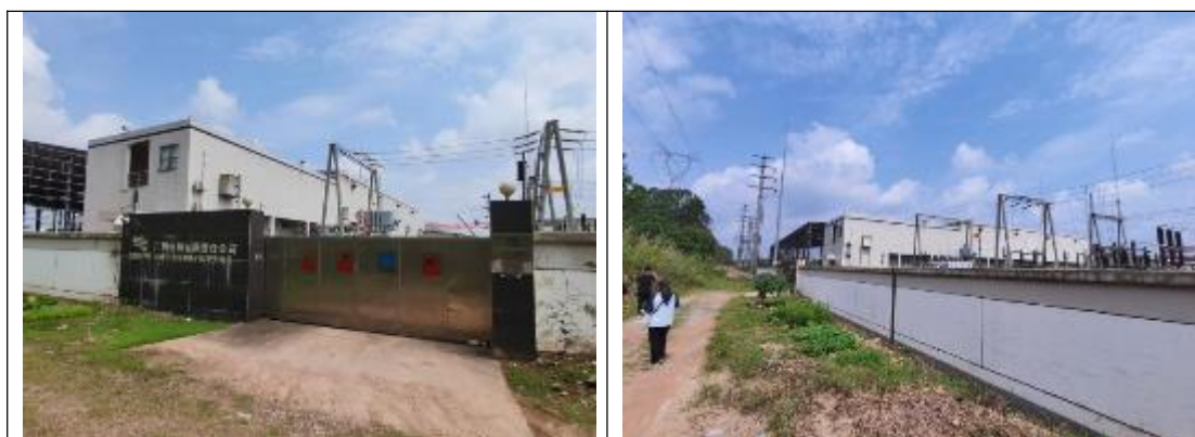
图 3 现场调查照片
